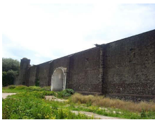
40 de 64 Troje Inmueble Troje I-0012107816, Conjunto Arquitectónico Puebla, San José Chiapa, San José Chiapa Camino a la Ex Hacienda Ozumba Siglo XVIII
