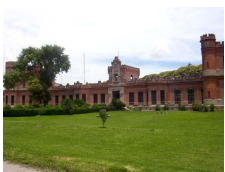
34 de 64 Antigua Hacienda de Ozumba Inmueble Hacienda I-0012107810, Conjunto Arquitectónico Puebla, San José Chiapa, San José Chiapa Camino a la Ex Hacienda Ozumba Siglo XVIII
