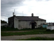
43 de 64 Casa del administrador Inmueble Casa del administrador I-0012107819, Conjunto Arquitectónico Puebla, San José Chiapa, San José Chiapa Camino a la Ex Hacienda Ozumba Siglo XVIII
