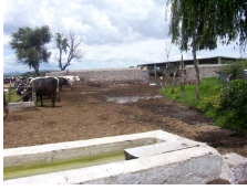
42 de 64 Corrales Inmueble Corrales I-0012107818, Conjunto Arquitectónico Puebla, San José Chiapa, San José Chiapa Camino a la Ex Hacienda Ozumba Siglo XVIII
