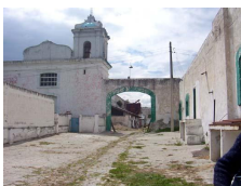
48 de 64 Establo Inmueble Establo I-0012107824, Conjunto Arquitectónico Puebla, San José Chiapa, San José Chiapa Camino a San Miguel Salado Siglo XIX
